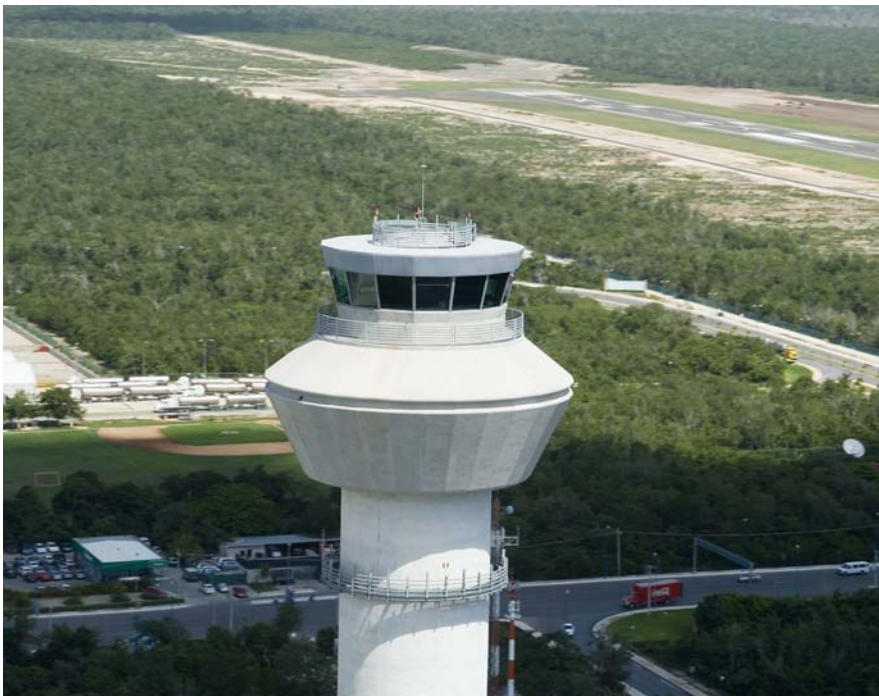
Vista aérea de la nueva torre de control del Aeropuerto de Cancún
